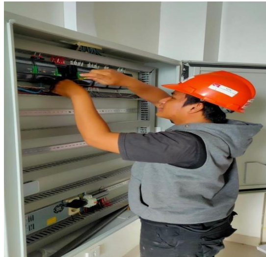
Gambar 2.2 Instalasi Panel DDC BAS
