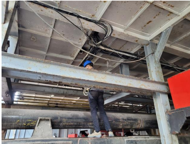
Gambar 2.2 Pemasangan kabel di tray
