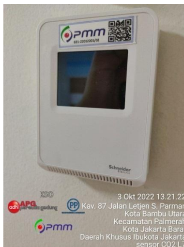
Gambar 2.4 Alat yang Digunakan di Proyek
