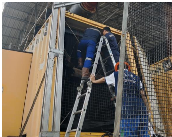
Gambar 2.6 Memperbaiki bocor radiator mesin CAT 3512
