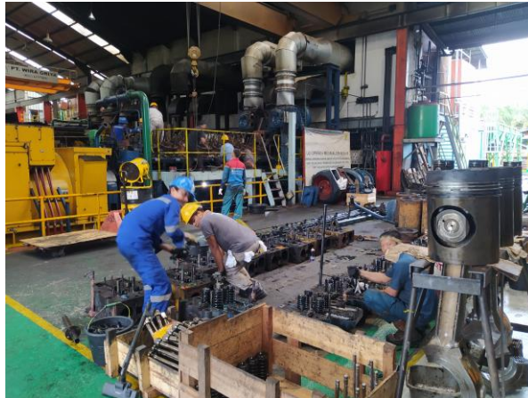
Gambar 2.1 Lingkungan Kerja Pemeliharaan
