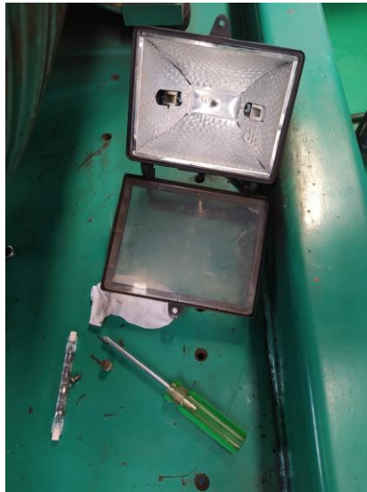
Gambar 2.5 Mengganti lampu pemanas generator mesin Cummins
