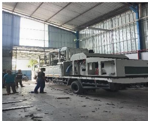
Gambar 19. Proses Pembongkaran Mesin di Plant 2
