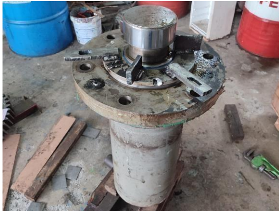
Gambar 9. Pemasangan Seal Pada Silinder Hidrolik
