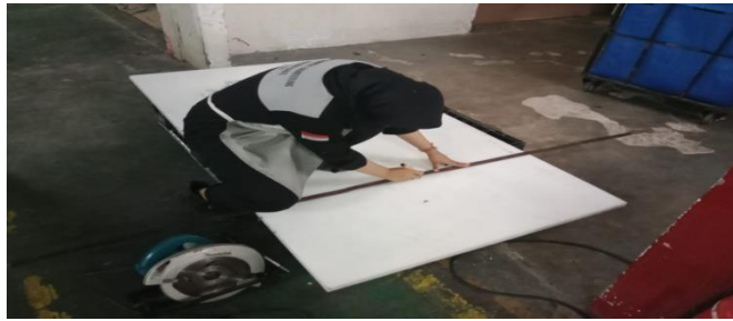
Gambar 2. 7 Pengukuran taplone
