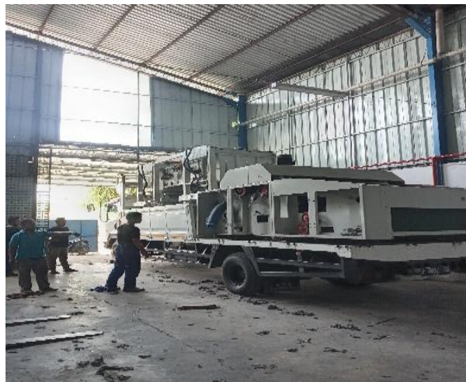
Gambar 2. 16 Proses Pembongkaran Mesin di Plant 2
