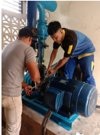
Gambar 2. 5 Proses Pemasangan Stuffing Box
