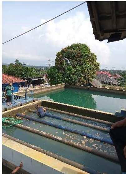
Gambar 2. 7 Proses Membersihkan Bak Penampungan Air
