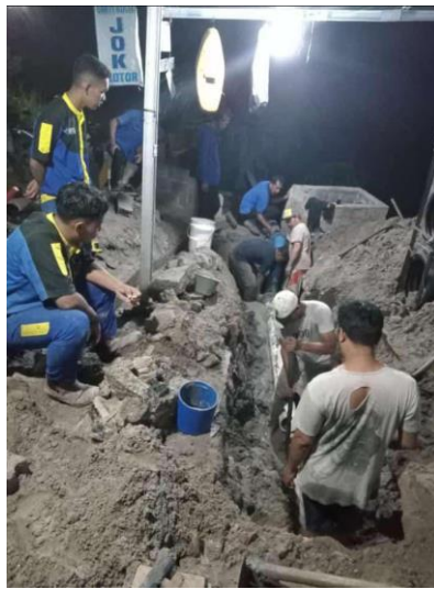
Gambar 2. 4 Proses Pemasangan Pipa
