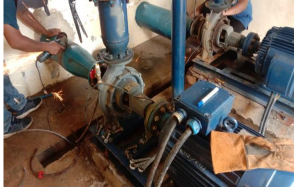
Gambar 2. 1 Perbaikan Pipa Transmisi
