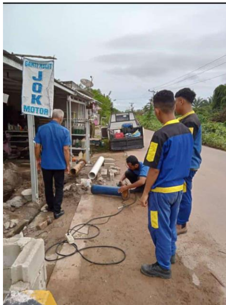
Gambar 2. 3 Proses Pemotongan Jaringan Pipa Distribusi
