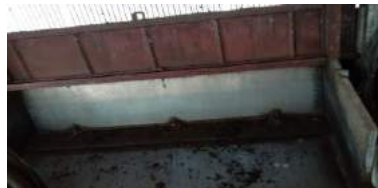
Gambar 2.4. Pintu Loading Ramp
