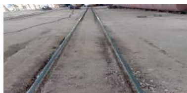
Gambar 2.10. Rel Loading Ramp
