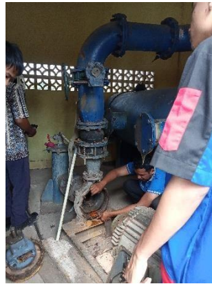
Gambar 2. 1 Perbaikan Pipa Transmisi
