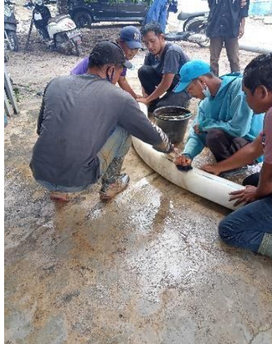
Gambar 2. 4 Proses Pemasangan Pipa
