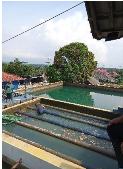
Gambar 2. 7 Proses Membersihkan Bak Penampungan Air
