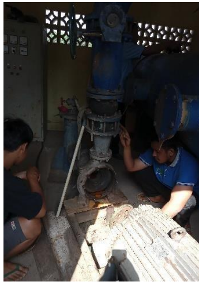
Gambar 2. 5 Proses Pemasangan Stuffing Box
