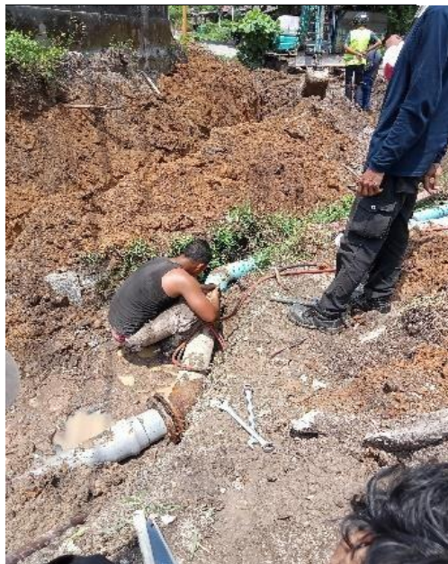
Gambar 2. 3 Proses Pemotongan Jaringan Pipa Distribusi
