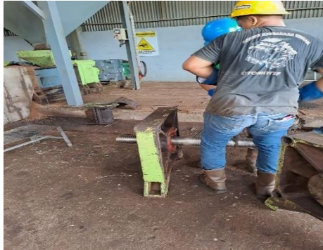
Gambar 2. 10 Pemasangan Main Shaft (Poros)
