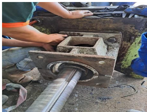
Gambar 2. 6 Pemasangan Feed Cage
