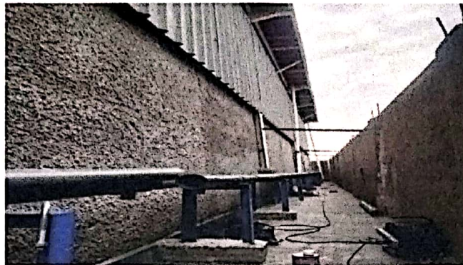
Gambar .1.13 Pemasangan Sapot Air
