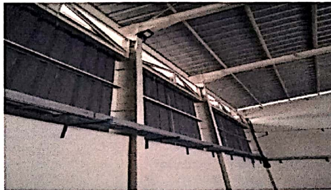
Gambar 1.15 Pemasangan Deking Kabel
