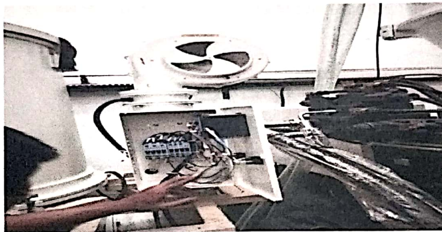
Gambar 1.08 Pemasangan Aliran Listrik
