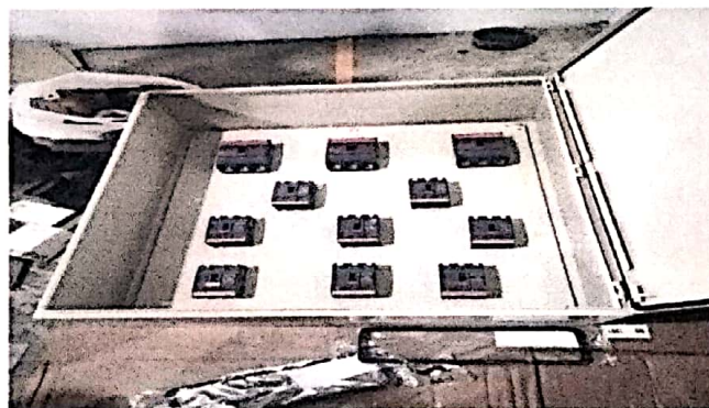
Gambar 1.16 Perakitan Gardu Listrik
