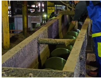
Gambar 2.3 Mengencangkan baut hangar ICBC
