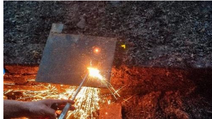
Gambar 2.6 Pemotongan Plat untuk menambal kebocoran Conveyor
