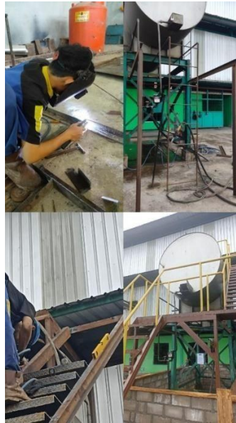
Gambar 2.1 Alur Proses Pembuatan Platform tangki solar
