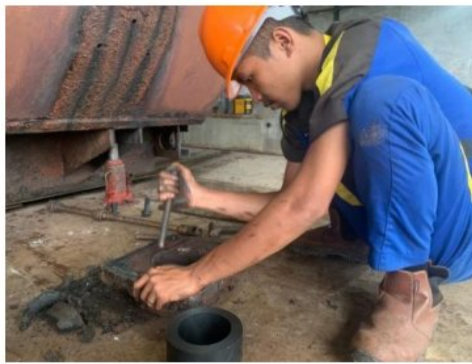
Gambar 2.2 Perbaikan bushing Lorry
