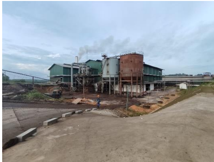
Gambar 1.2 Pabrik PT Payung Mitra Jaya Mandiri
