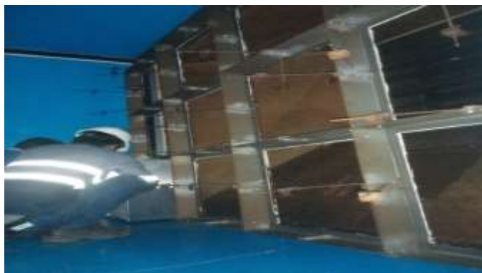
Gambar 2. 12 Dokumentasi Penggantian Filter AHU
