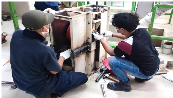
Gambar 2. 5 Pemasangan Part Sesudah Modifikasi
