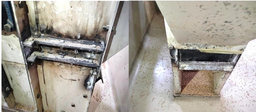
Gambar 2. 4 Hasil Housing Boot Bucket Elevator Setelah Modifikasi
