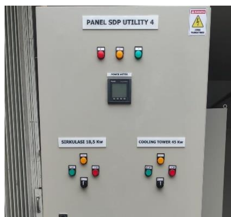
Gambar 2. 5 Contoh Komponen yang Terpasang pada Pintu Panel
