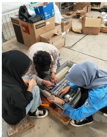
Gambar 2. 4 Pemasangan Komponen Panel
