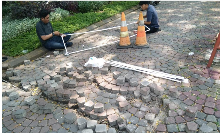
Gambar 2. 2 Kunjungan Proyek Komplek Perumahan Premier Serenity
