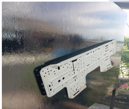
Gambar 4.12 Memasang bracket indoor
