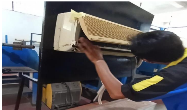
Gambar 4.14 memasang indoor ac
