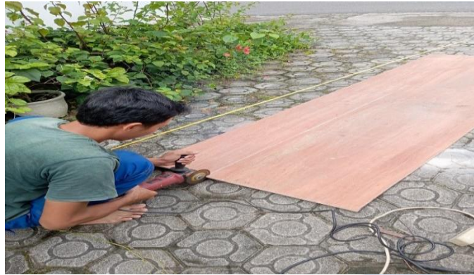
Gambar 4.6 pengukuran dan pemongan triplek
