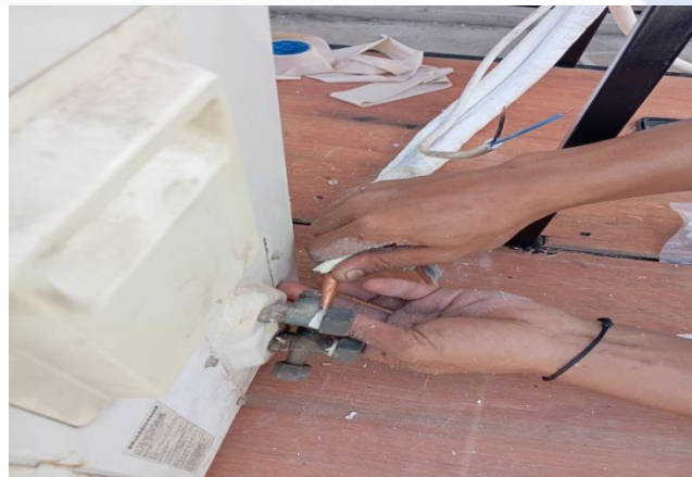
Gambar 4.16 memasang pipa kapiler pada AC
