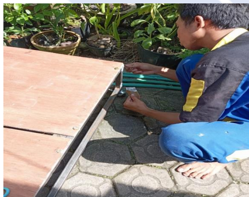
Gambar 4.9 pendempulan rangka platform media ajar
