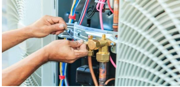
Gambar 4.17 Memasang kabel listrik pada AC
