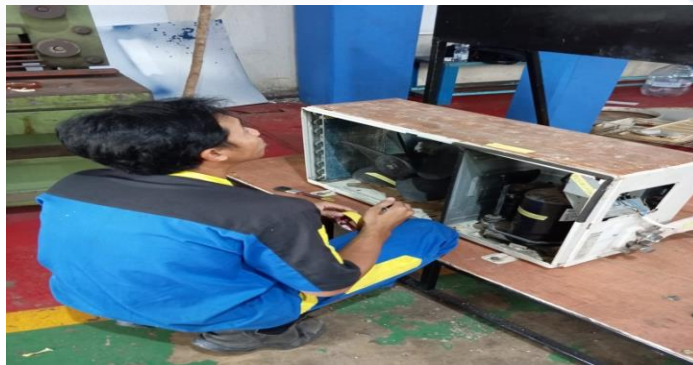
Gambar 4.190 pembersihan kondensor AC split
