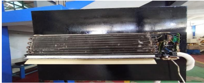
Gambar 4.189 pembersihan evaporator pada AC
