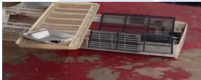
Gambar 4.18 pembersihan filter udara
