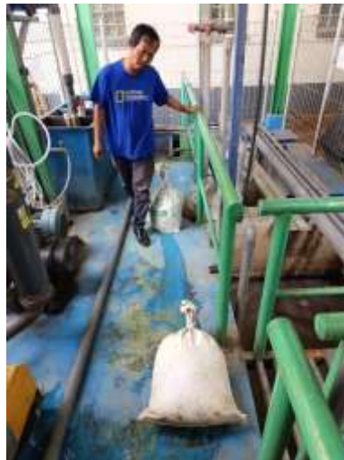
Gambar 2.22 Penambahan lumpur aktif WWTP
