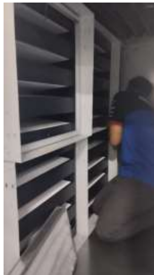
Gambar 2.31 Pengecekan bagian filter AHU
