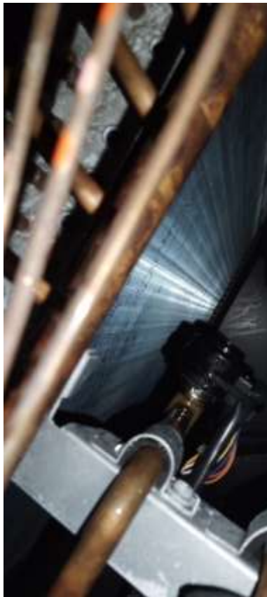
Gambar 2.35 Pengecekan evaporator FCU ducting
