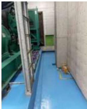
Gambar 2.14 Pengecekan Sisi Kanan Genset
