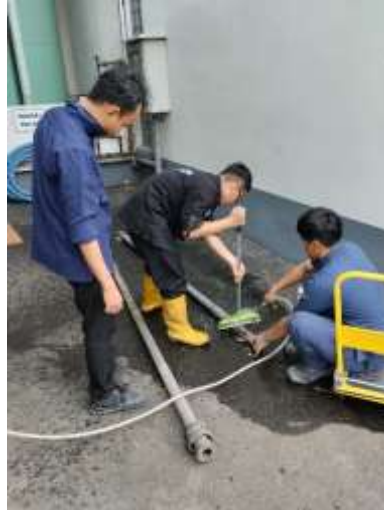
Gambar 2.23 Pembersihan pipa mampet
