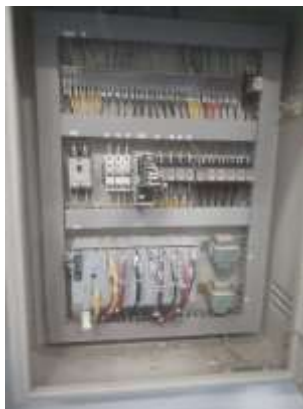
Gambar 2.11 Pengecekan panel dalam
