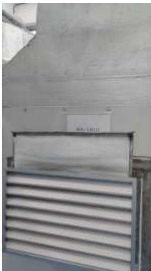
Gambar 2.33 Pengecekan bagian filter AHU
