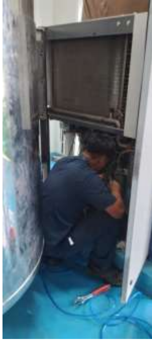
Gambar 2.13 pengecekan Kompresor
