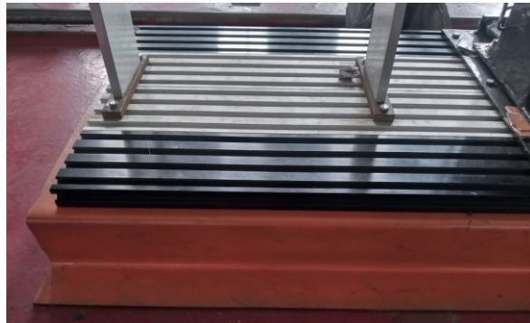
Gambar 4. 6 Pemasangan Alumunium profil
