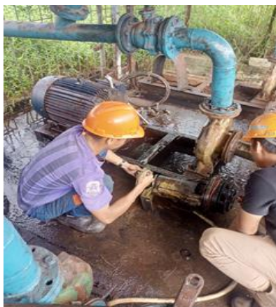
Gambar 2. 15 Penggantian Bearing Kolam Limbah
