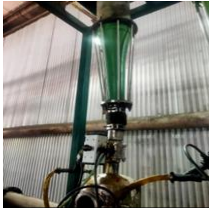
Gambar 2. 8 Perbaikan Sand Cyclone
