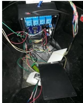
Gambar 4.17 Peletakan Box Panel
