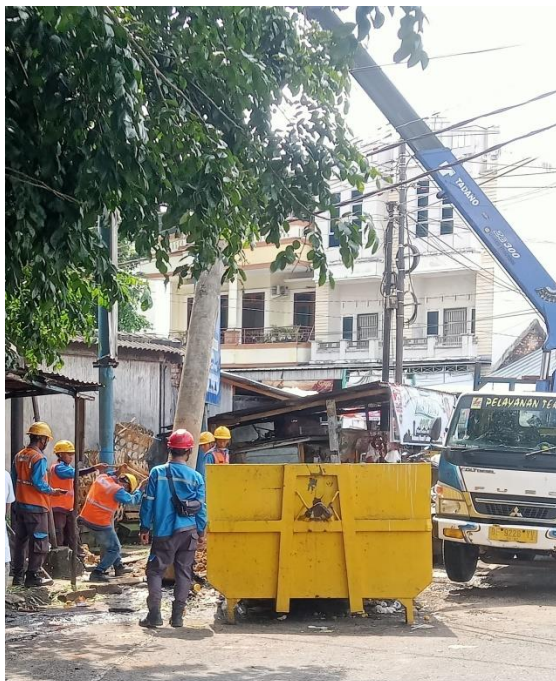
Gambar 2.26 Proses tanam tiang yang dipindahkan
