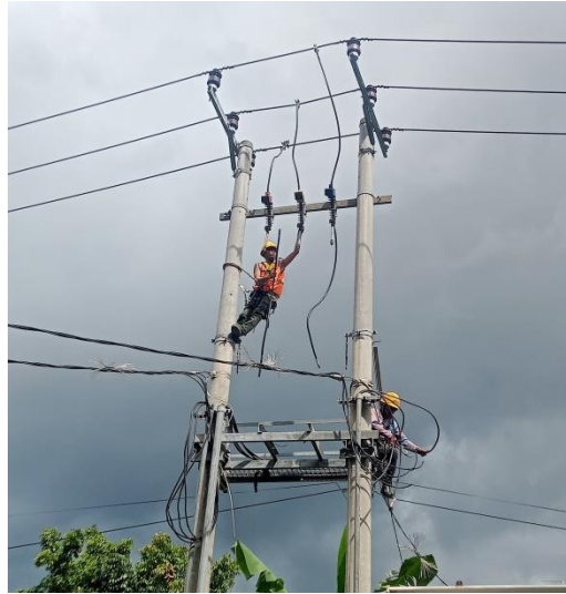
Gambar 2.30 Proses pembongkaran kontruksi gardu distribusi
