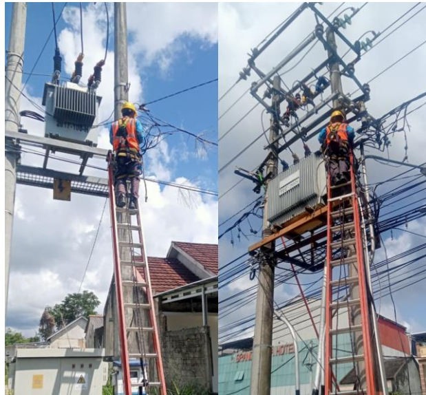
Gambar 2.21 Proses pengecekan dan perbaikan komponen gardu distribusi
