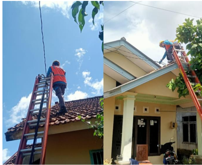
Gambar 2.22 Proses pengencangan dan penyambungan kabel SR pelanggan yang bermasalah
