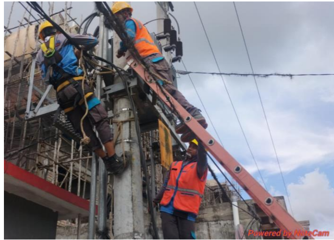
Gambar 2.36 Proses pemasangan kontruksi TR
