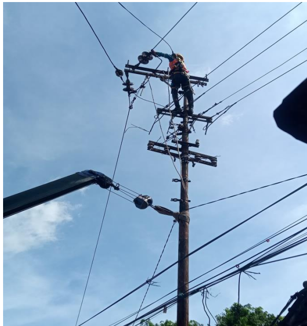
Gambar 2.24 Proses pembongkaran konstruksi TM dan SUTM
