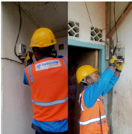
Gambar 2.20 Proses perbaikan KWH meter pelanggan yang mengalami gangguan
