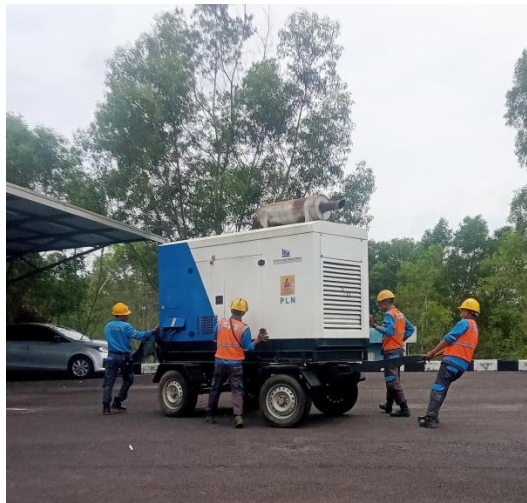
Gambar 2.29 Proses pembongkaran UPS PESTA
