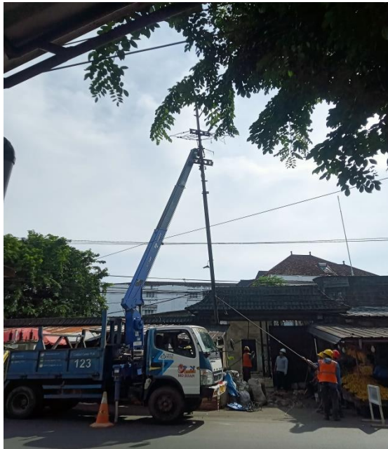
Gambar 2.25 Proses cabut tiang yang akan dipindahkan
