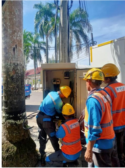
Gambar 2.28 Proses pembongkaran genset PESTA
