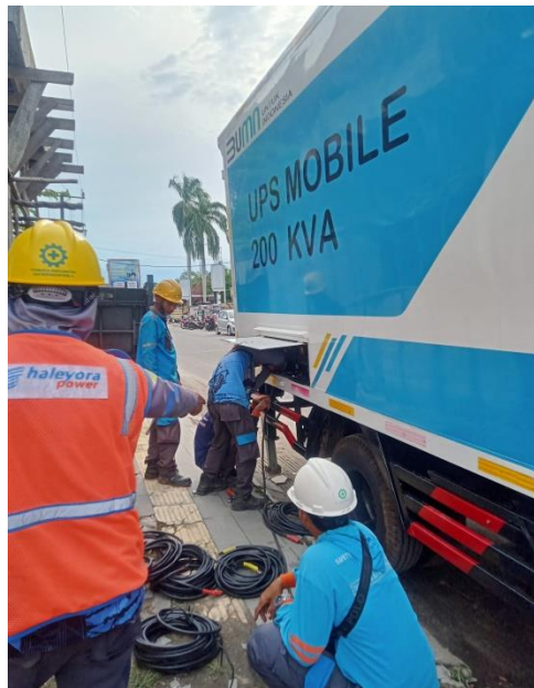
Gambar 2.27 Proses pemasangan UPS PESTA
