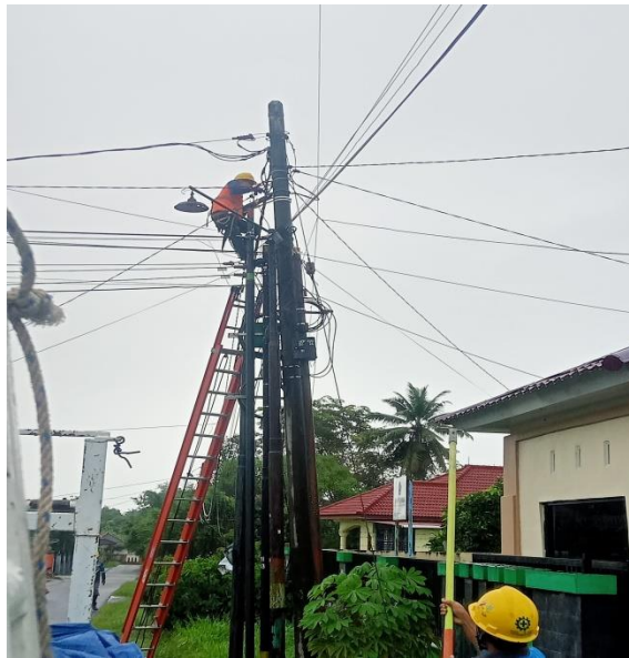
Gambar 2.17 Proses pemerataan beban gardu distribusi
