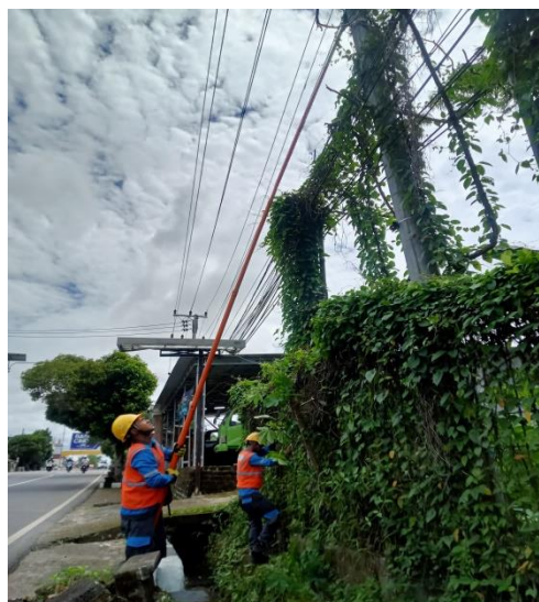
Gambar 2.23 Proses pemangkasan tanaman yang merambat di jaringan TM
