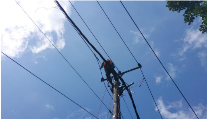
Gambar 2.38 Proses pengencangan SUTM
