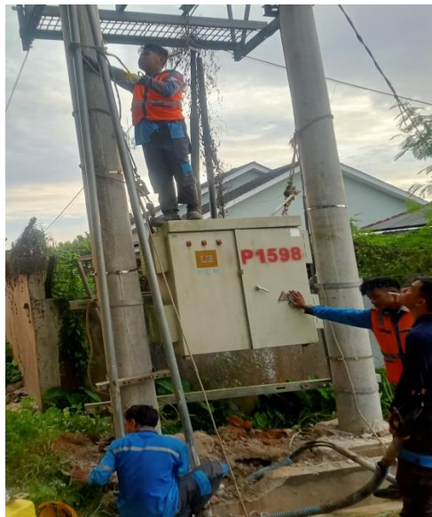
Gambar 2.31 Proses bongkar PHB-TR gardu distribusi
