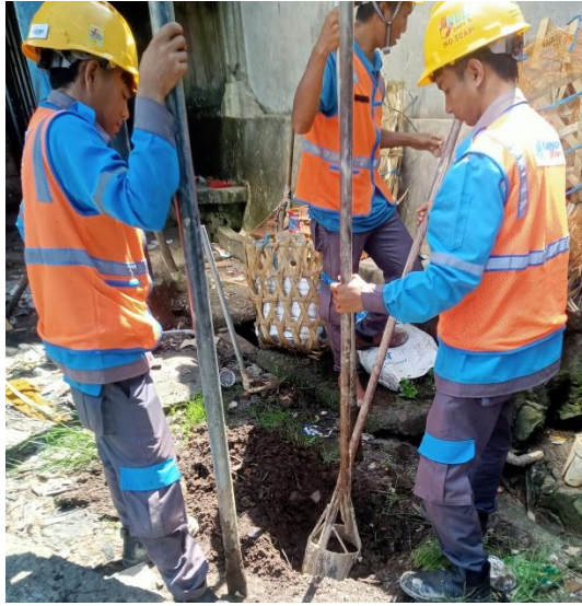
Gambar 2.19 Proses penggalian lobang untuk tiang yang akan dipindahkan
