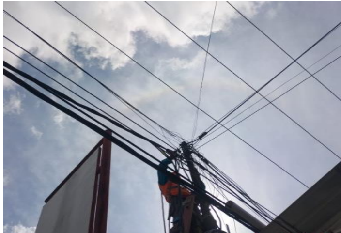
Gambar 2.35 Proses bongkar kontruksi TR
