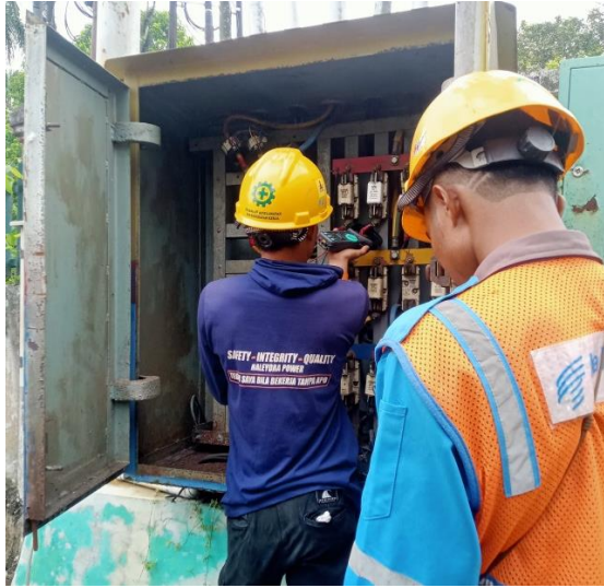
Gambar 2.18 Proses pemeriksaan tegangan arus setelah pemerataan beban
