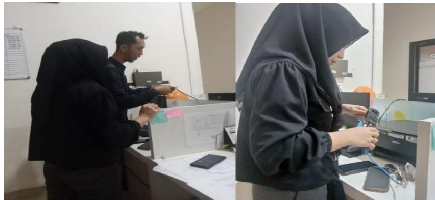
Gambar 2.10 Melakukan Penyambungan Kabel Jaringan LAN
