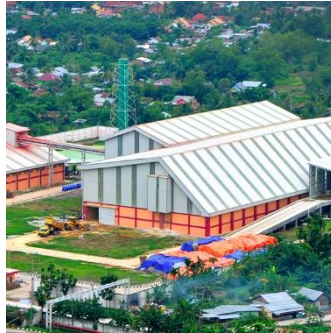
Gambar 1.11. Pabrik NPK Fusion 1 [1]
