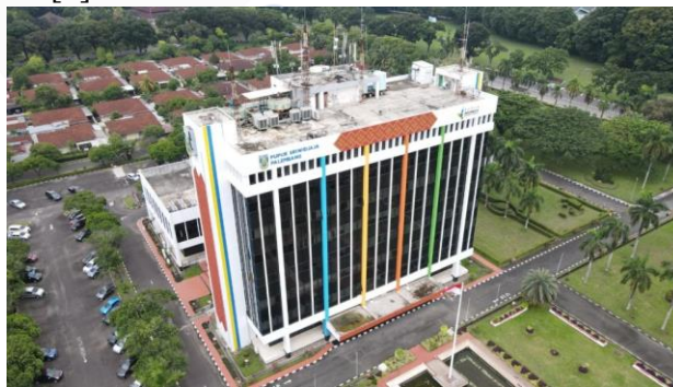
Gambar 1.1. Gedung Utama PT. Pusri Palembang [2]
