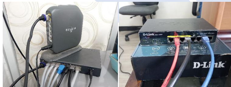
Gambar 2.22. Port POE Dari NVR Ke POE Switch
