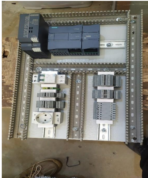
Gambar 2. 3 Pemasangan Kabel Duct, Din Rail dan Komponen-Komponen
