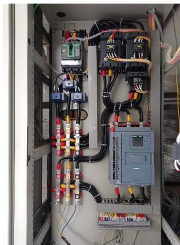
Gambar 2. 16 Pemasangan Kabel Interkoneksi pada Panel LCP Transfer Conveyor
