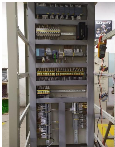
Gambar 2. 14 Pengerjaan wiring PLC Panel
