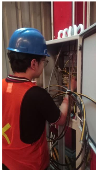
Gambar 2. 10 Pengerjaan Pemasangan Terminasi Incoming
