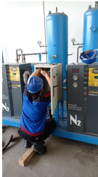
Gambar 2. 13 Pengerjaan penggantian MCB 32A ke 50A
