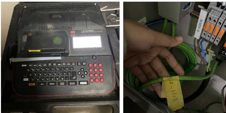
Gambar 2. 13 Tagging dan Labeling Kabel Wiring Panel
