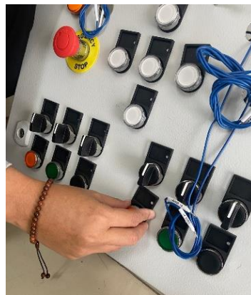
Gambar 2. 15 Merapikan Name Plate pada Pintu Panel
