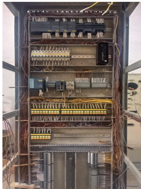
Gambar 2. 14 Pengerjaan Wiring Panel PT. Berkat Nirwana Teknik
