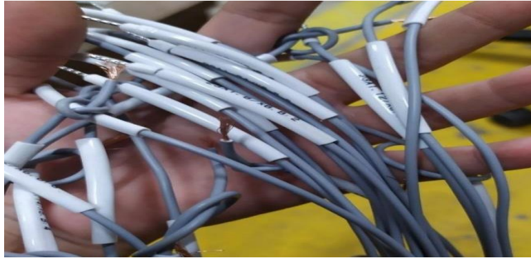
Gambar 2. 3 Pemasangan Tagging Address Kabel
