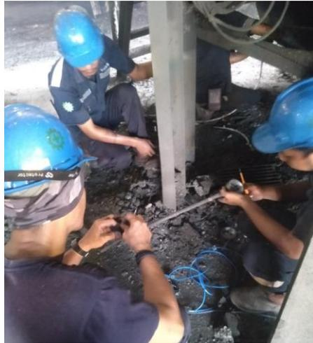
*Gambar 2. 5 Penggantian Kabel pada Thermocouple yang*
