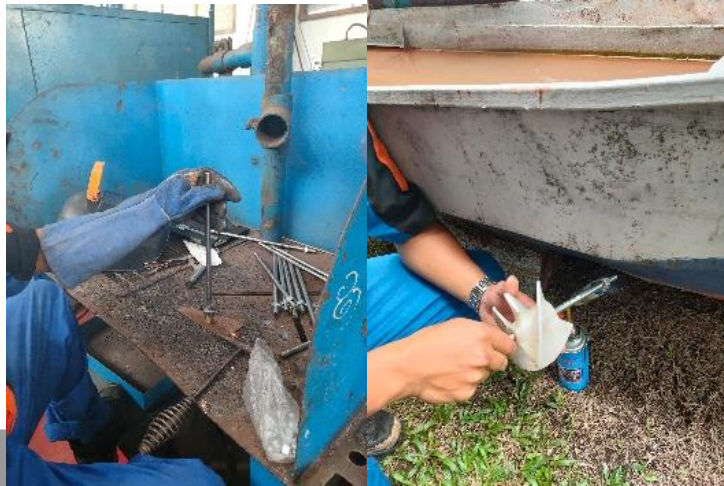
Gambar 3. 10 Penyambungan Mur dengan Poros dan Perekatan Impeller Pada Mur
