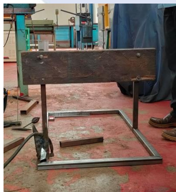
Gambar 3. 12 Proses Pembuatan Dudukan Mesin
