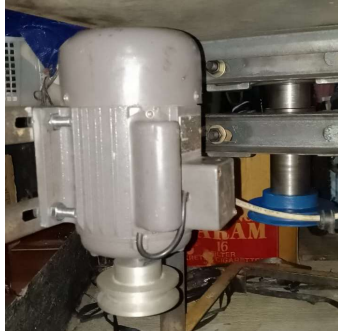
Gambar 3. 11 Pemasangan Motor AC
