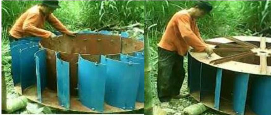
Gambar 2. 4 Contoh Penerapan Sistem *Knockdown* pada Ring Utama yang diterapkan pada Kincir Air
