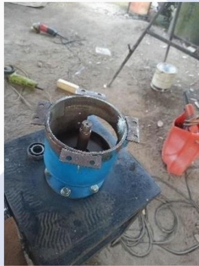
Gambar 4.10 Pemasangan Poros Utama
