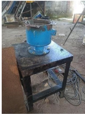
Gambar 4.9 Pemasangan Tabung Bawah
