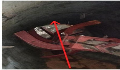
Gambar 4. 3 Liner Bottom Plate (Sumber : PT. Gunung Maras Lestari-POM, 2023)
