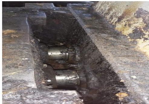
Gambar 4.4 Oil Seal Pada Gearbox Reduser (Sumber: PT. Gunung Maras Lestari, 2023)
