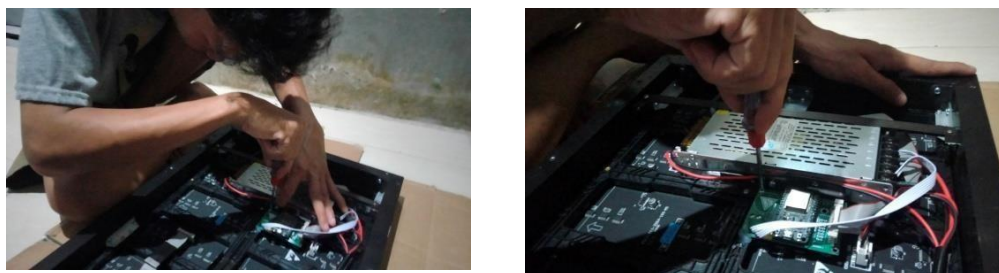
Gambar 4.2 Peletakan Komponen Pada Panel
