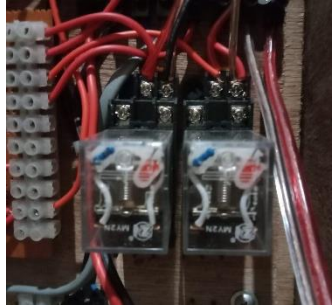
Gambar 3.14 Pemasangan relay 220V
