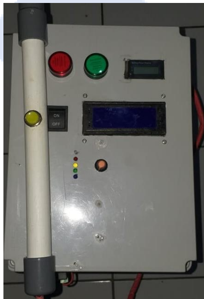
Gambar 4. 3 Pemasangan Komponen Bagian Depan Box
