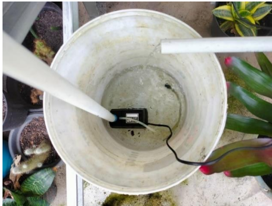
Gambar 4.5 Pompa Pada Tangki Pencampuran
