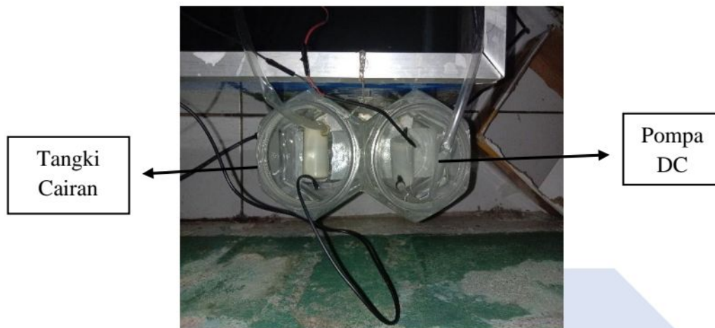
Gambar 4. 12 Pemasangan Tangki Cairan dan Pompa DC
