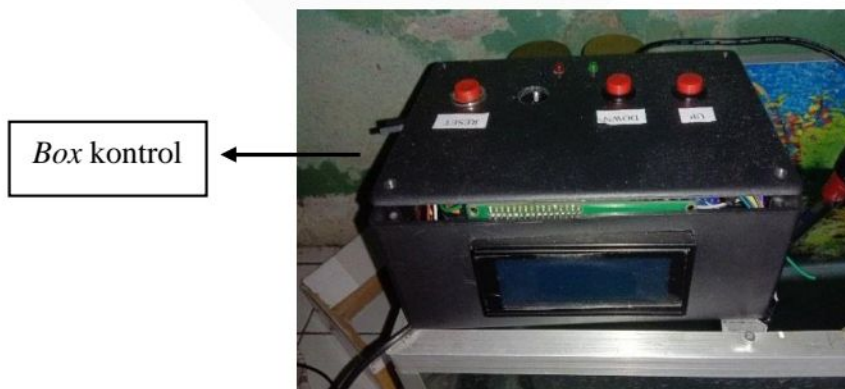
Gambar 4. 5 Pemasangan Box Kontrol
