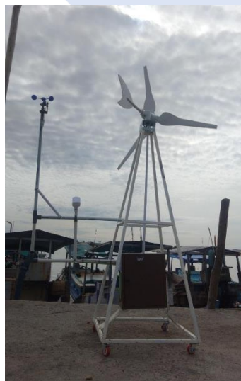
Gambar 4. 26 Pembangkit listrik tenaga angin secara keseluruhan
