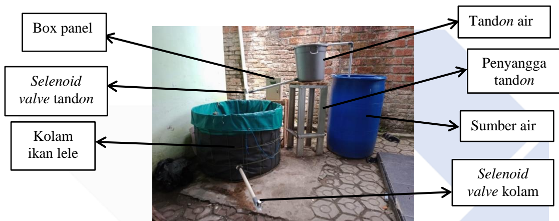
Gambar 4.6 Hardware Non-Elektrik Tampak Depan
