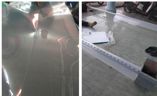
Gambar 4.3 Pembuatan kontruksi dari fiber atau pipa
