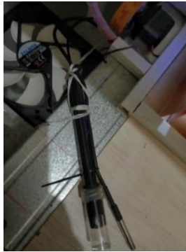
Gambar 4. 10 Pemasangan Sensor suhu DS18B20
