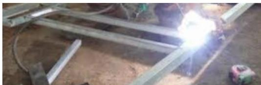
Gambar 3. 3 Proses pengelasan pada hollow persegi
