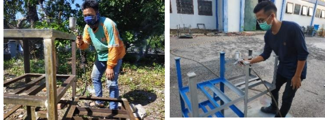
Gambar 4. 16. Pelapisan epoxy dan pengecatan
