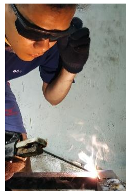
Gambar 4. 12. Pemasangan komponen rangka dengan cara dilas
